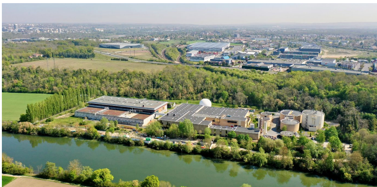
vue aérienne de la station de Neuville-sur-Oise - 2021
